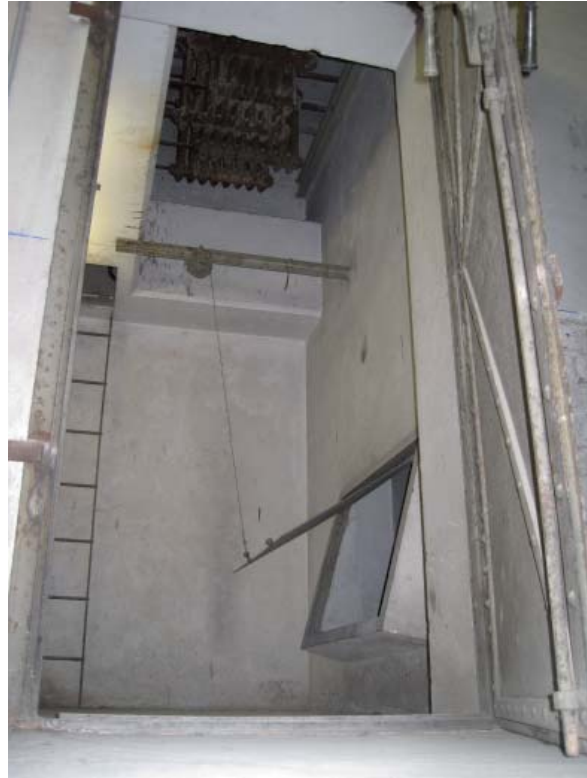
Abb. B.20: Blick in Luftheizkammer IV mit Regulierklappe und Radiatoren unter der Decke
