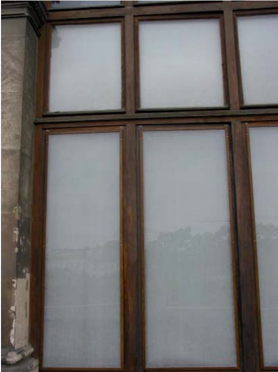
Abb. C.40: Die Beschattungsrahmen sind mit 10 mm Konvektionsabstand auf den Außenflügeln montiert. Die obere Fensterreihe im linken Bild zeigt den Bestand der tischlerisch sanierten Fenster; die untere Fensterreihe ist mit dem Prototyp-Vorsatzrahmen ausgestattet (OG1 Marmorsaal der SAM). In der zuletzt ausgeführten Version, können die Rahmen zum Putzen weggeklappt werden (rechts).
