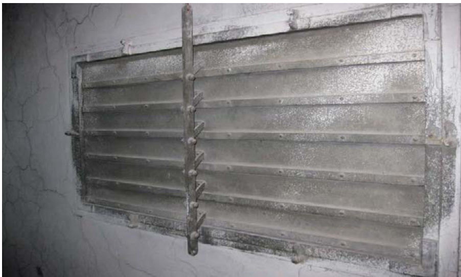
Abb. B.36: Eine der beiden letzten original erhaltenen Jalousienklappen in Saal 7 der HJRK
