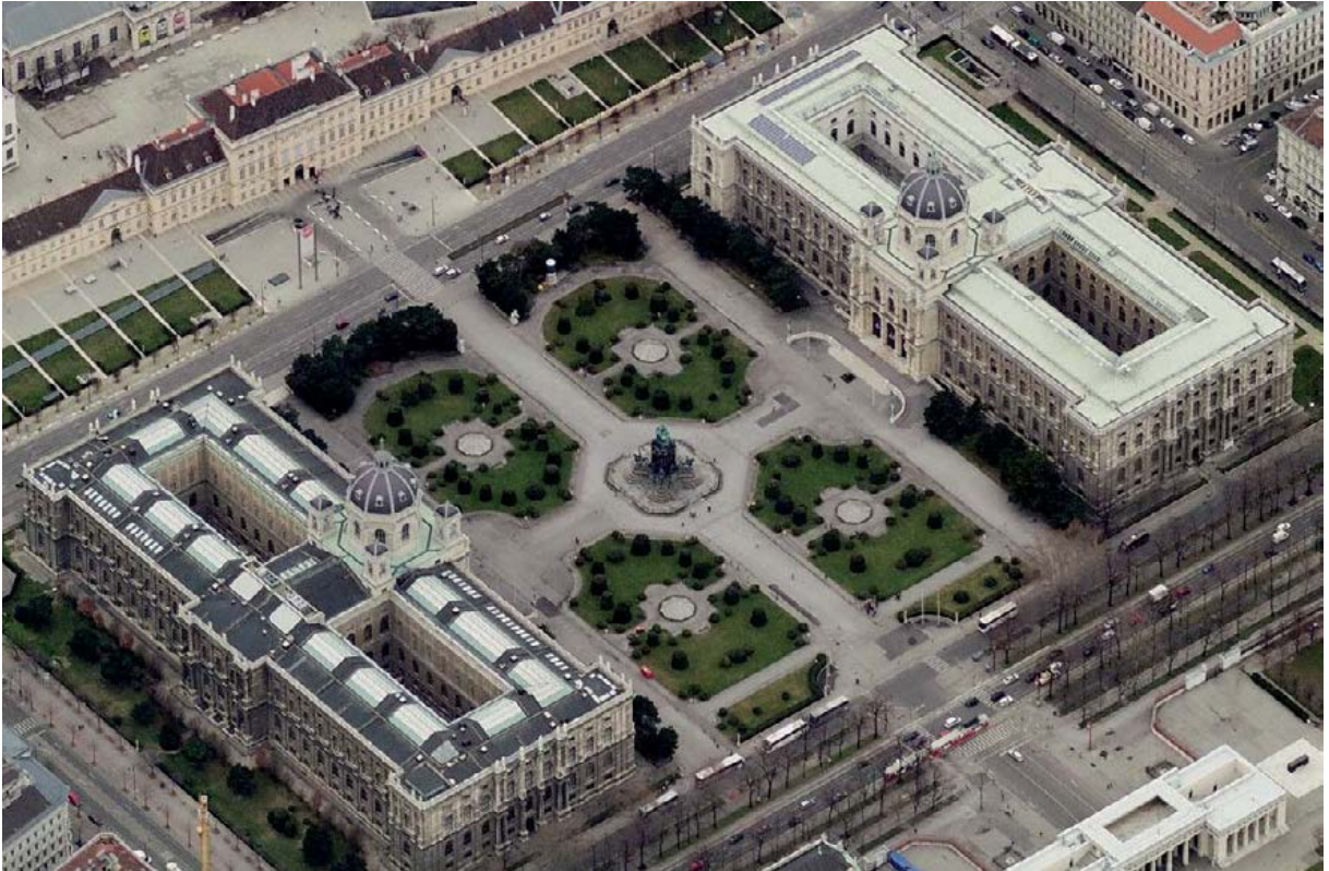
Abb. B.7: Ausgebautes und aufgestocktes Dach des Naturhistorischen Museums (rechts) (Foto: www.bing.com/maps ; 19.05.2011)
