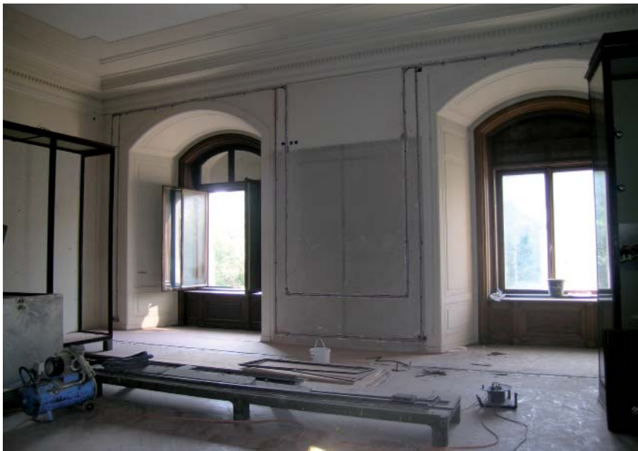
Abb. A.21: Einbau der Wandtemperierung im Mezzanin des MVK
