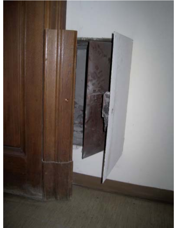
Abb. B.64: Die originale Revisionstüre von Schacht Nr. 17 war vom Türstock verbaut (links). Durch Trennen des Stocks und Einbau von Scharnieren konnte die Tür zugänglich gemacht werden (Mitte, rechts).
