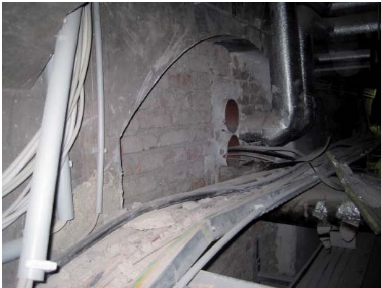
Abb. B.73: Zugemauerte horizontale Verbindungsöffnung vom Hauptkollektor im Segmentbogen in den Mittelbau
