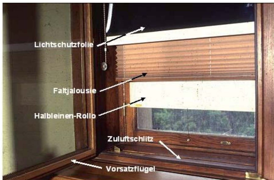
Abb. A.19: Alle Fenster der SAM wurden mit dreifachem Lichtschutz, innerem Vorsatzflügel und Fensterkastenbelüftung ausgestattet. (Bildmontage: Florian Wicke)
