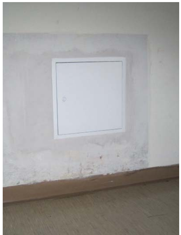
Abb. B.65: Originale Tür am Fußpunkt von Schacht Nr. 25 (links); neue Revisionstür (2010) Schacht Nr. 7 (rechts)
