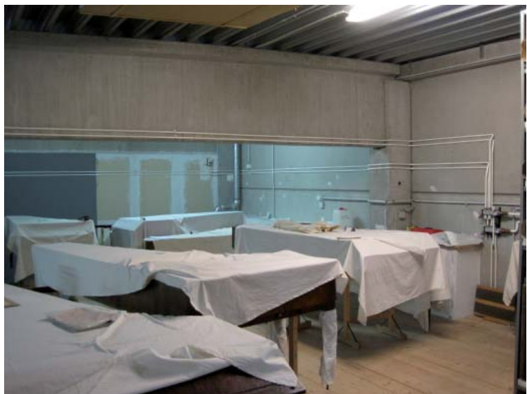
Abb. C.24: Das Klavierdepot der SAM wurde nachträglich mit einer auf die Betonaußenwände applizierten Bauteiltemperierung ausgestattet.
