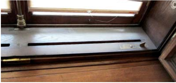
Abb. D.2: Die Schuber unter den Fensterbrettern müssen während der Heizperiode verschlossen sein
