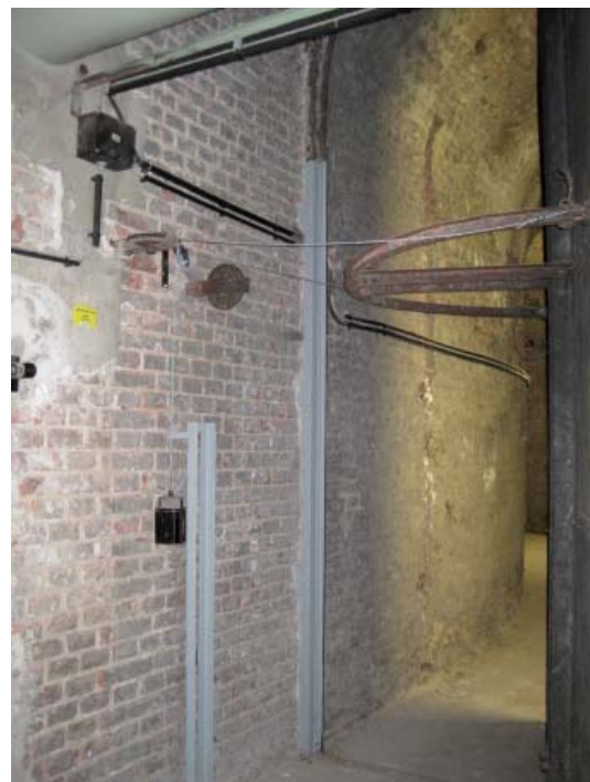
Abb. C.11: Die Drehtür wird nach dem Umbau vom 8 kg-Gewicht zugezogen und mit einem Schrittmotor in drei Positionen offen gehalten. Die als Seilspanner fungierende bewegliche Rolle (Pfeil) sorgt dafür, dass der Seilzug beim manuellen Aufdrücken der (halb) geschlossenen Drehtür nicht aus den Rollen springt und die Tür sich nach dem Durchgang wieder schließt. (Der hier provisorisch montierte Garagenmotor erwies sich als zu schwach und muss durch einen Spindelmotor ersetzt werden.)
