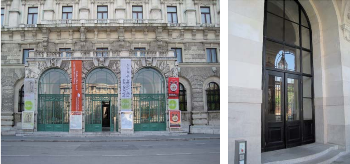
Abb. B.82: Eingang ins Corps de Logis. Das äußere Tor ist untertags ständig geöffnet (links). Die drei Flügeltüren zum Vestibül verfügen über keine Klimaschleusen.
