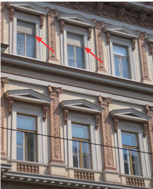
Abb. B.9: Zur Ansaugöffnung einer Lüftungsanlage umgebaute Fenster an der Northwest-Fassade der Akademie der bildenden Künste
