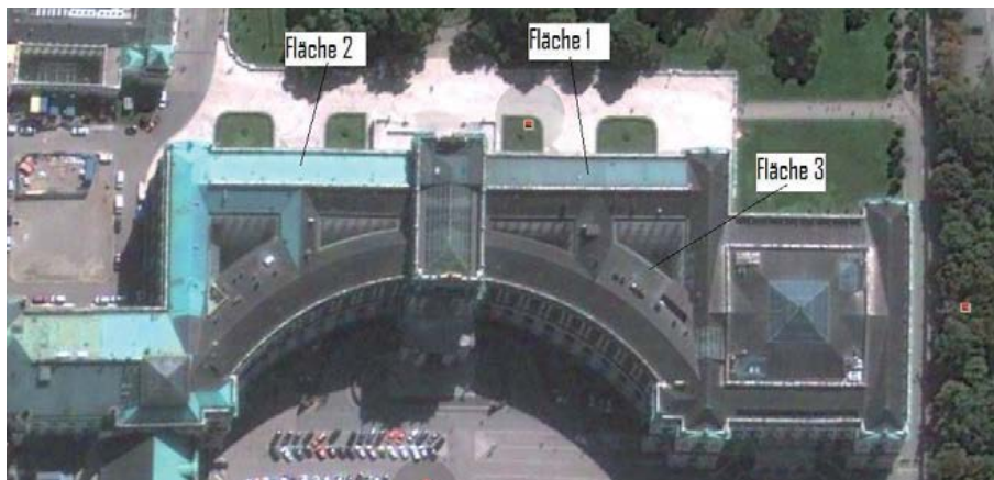
Abb. C.48: Für Photovoltaik-Nutzung geeignete Dachflächen der Neuen Burg
