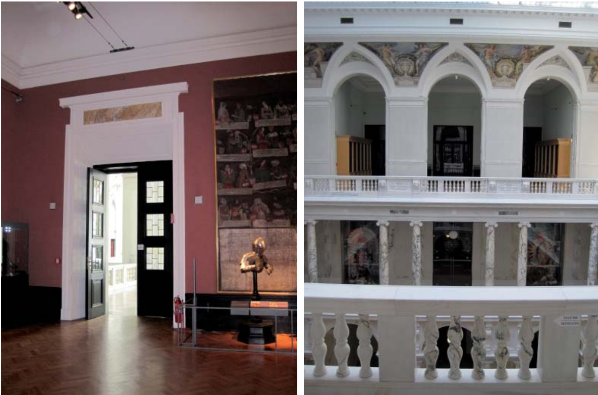
Abb. B.86: Die Türen zu den Galerien A - D verfügen über keine Türschließer und bilden keine funktionierenden Klimaabschnitte.
