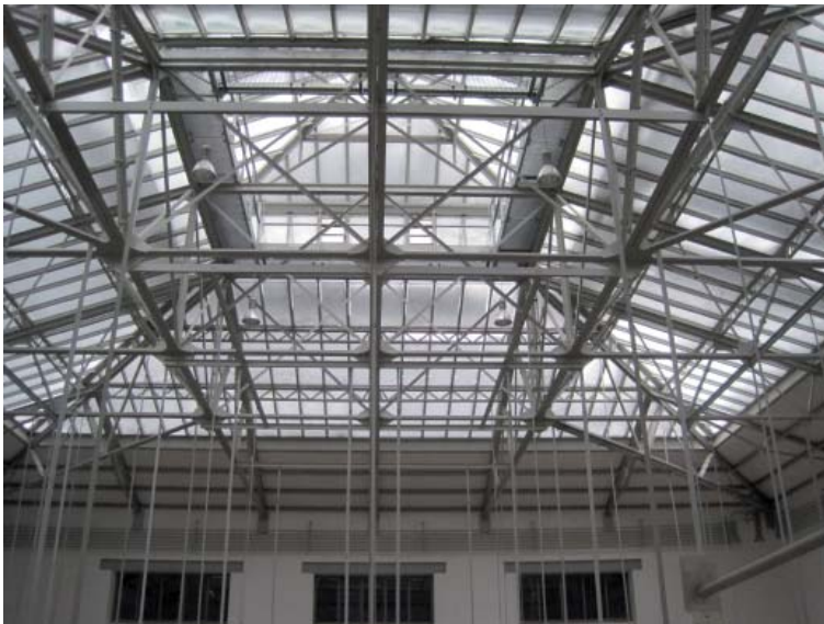
Abb. B.109: Über die mit transparenter Isolierverglasung ausgestatteten Lichtdächer findet ein hoher solarer Strahlungseintrag in den Gebäudekern statt. Die Wärmeabfuhr durch konvektive Entlüftung ist nahezu wirkungslos. Links: Glaspypamide über der Säulenhalle des Corps de Logis. Rechts: Glasdach zur Belichtung des Franz-Saales im Bildarchiv der ÖNB
