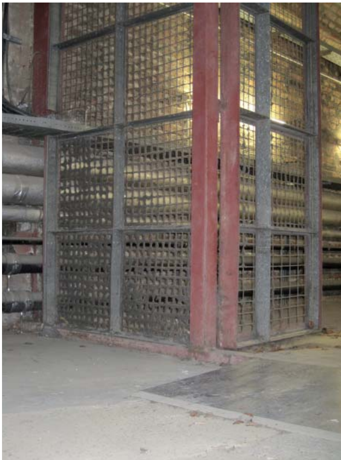
Abb. B.77: Durch Staubflusen verschmutztes Gitter im Einlassbereich des Hauptstollens bei der Gittertür
