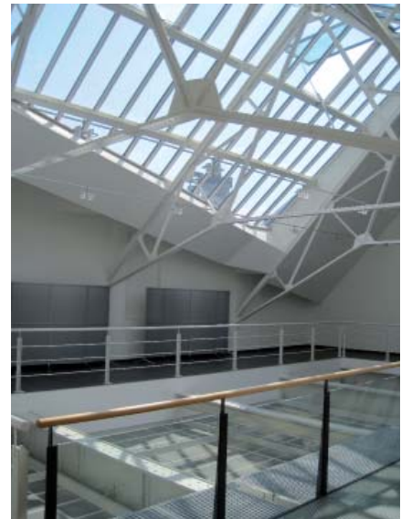
Abb. B.109: Über die mit transparenter Isolierverglasung ausgestatteten Lichtdächer findet ein hoher solarer Strahlungseintrag in den Gebäudekern statt. Die Wärmeabfuhr durch konvektive Entlüftung ist nahezu wirkungslos. Links: Glaspypamide über der Säulenhalle des Corps de Logis. Rechts: Glasdach zur Belichtung des Franz-Saales im Bildarchiv der ÖNB
