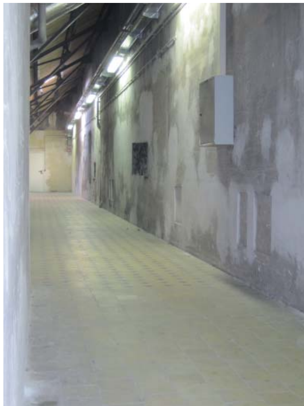
Abb. B.76: Zugemauerte Revisionstüren der Ventilationsschächte auf dem Dachboden
