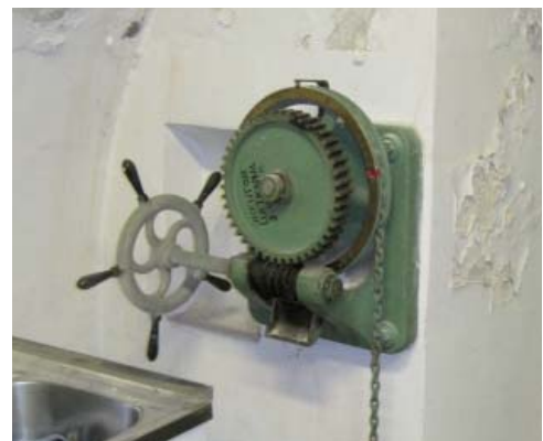
Abb. A.7: Steuerelement zum Bewegen der Drehtür mittels Kettenzug
