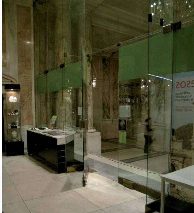
Abb. B.81: Die Pendeltür zur Kasse der Sammlungen des KHM wird durch Zugluft bis zu 45° aufgedrückt
