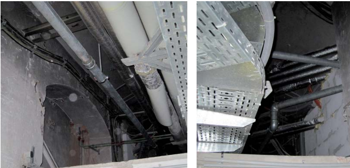
Abb. B.61: Einmündung der ehemaligen Lufteintrittsöffnungen vom 2. Keller des Corps de Logis in den Mittelbau (jetzt vermauert); links: nördliche Lufteinmündung in den Segmentbogen; rechts: südliche Lufteinmündung in den Kollektorgang
