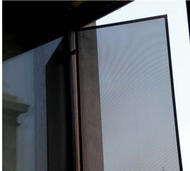
Abb. C.40: Die Beschattungsrahmen sind mit 10 mm Konvektionsabstand auf den Außenflügeln montiert. Die obere Fensterreihe im linken Bild zeigt den Bestand der tischlerisch sanierten Fenster; die untere Fensterreihe ist mit dem Prototyp-Vorsatzrahmen ausgestattet (OG1 Marmorsaal der SAM). In der zuletzt ausgeführten Version, können die Rahmen zum Putzen weggeklappt werden (rechts).
